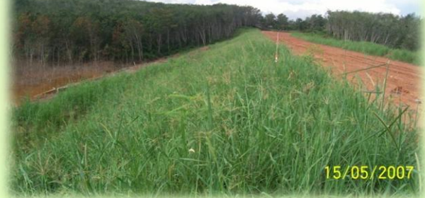
Revegetasi sebagai pengendali erosi soft erosion control.
